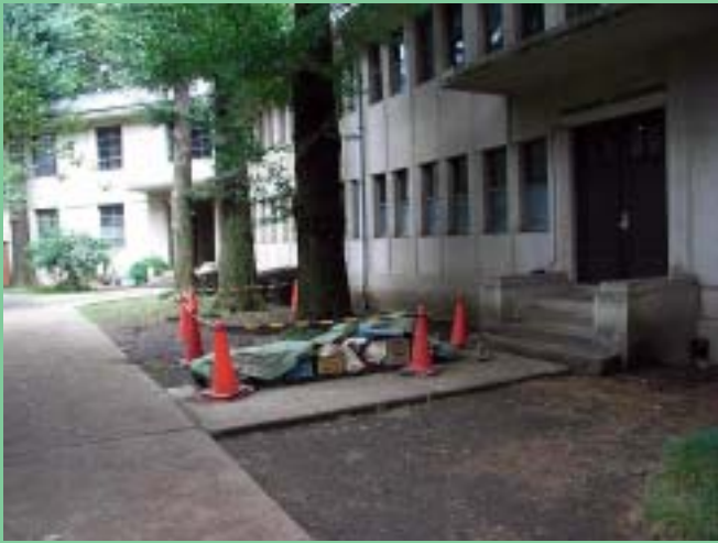
これは解体前の集会室へ至る場所。左奥に集会室が見える。
