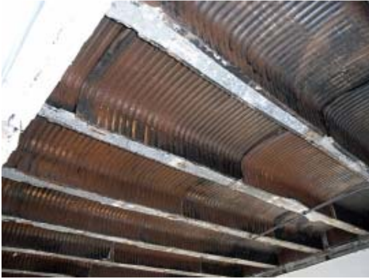
2階の床はかまぼこ状の鉄板張って、その上にコンクリートを打つ合理的工法（シンポジウム藤岡先生説明）。それが1階の天井に見える。
