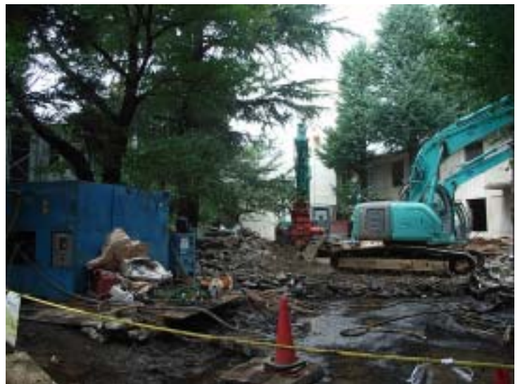
東寮と集会室の連結部分。
