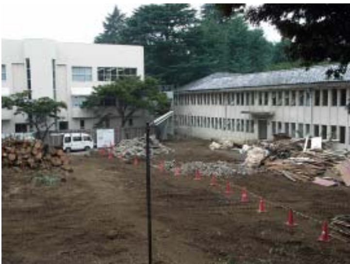
東寮前の木々はすべて伐採され、空虚な更地になっている。
