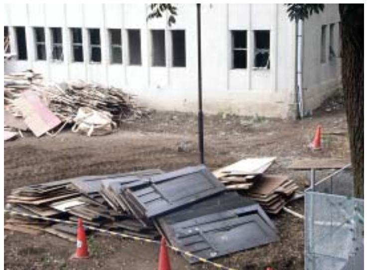
取り外されたドアが積み上げてある。
