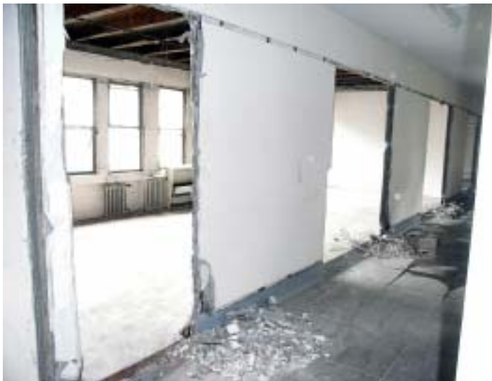
正面玄関に入って左手の部屋。ドアはすべて外されている。
