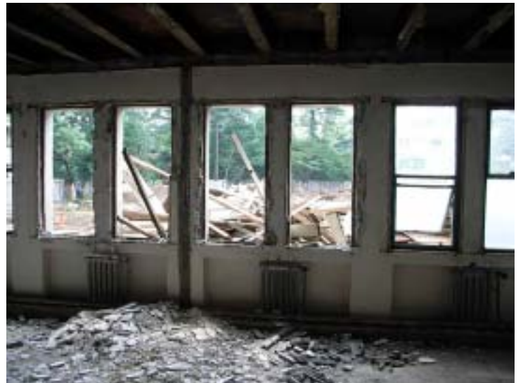
窓枠は一部が外されている。
