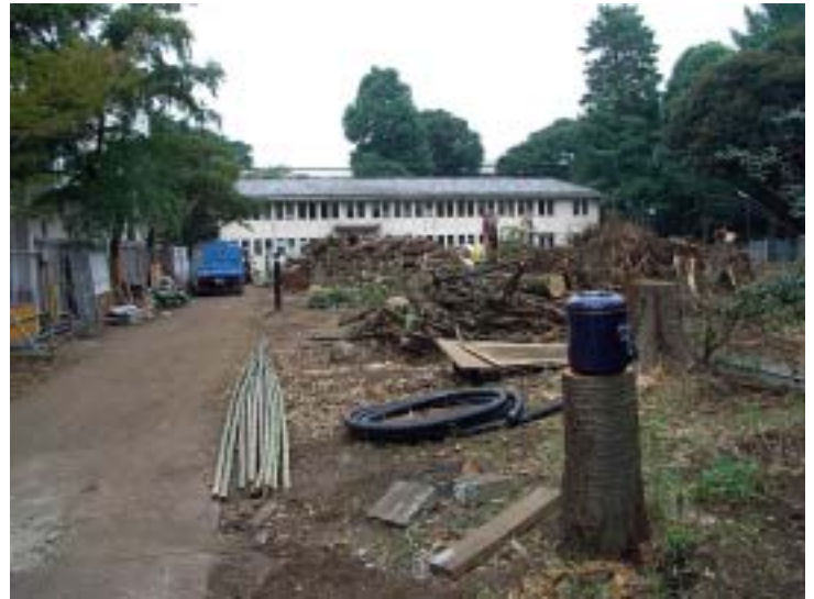
塀の隙間から中の様子を撮影。
