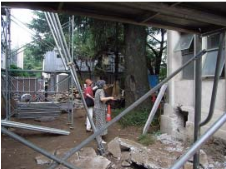
東寮正面から集会室の方へ回る。壁面に礎石を外した跡。
