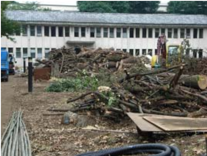
塀の間から最大限ズームアップして東寮を望む。
