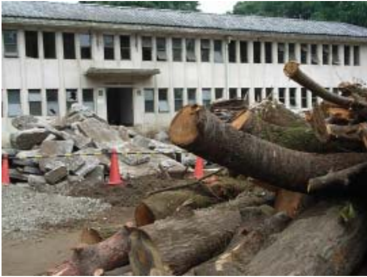
東寮正面玄関前。コンクリートの瓦礫は小道の舗装をはがしたもののか？
