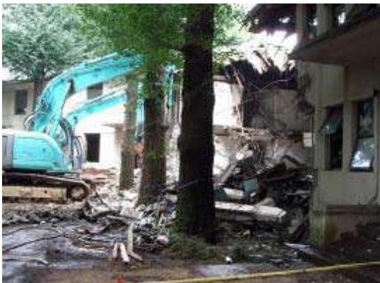
通用口、集会室へいたる部分の解体
