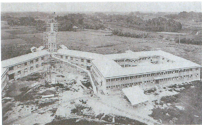
写真1 | 完成間近の東京女子大学東寮 (1923 [大正12] 年7月25日撮影) 1923年9月1日の関東大震災を生き抜いた、キャンパスに最初に建てられた建築物。
