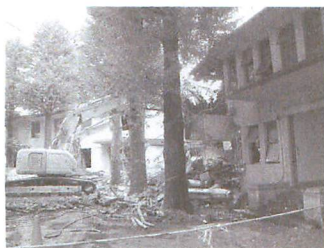
写真4 | 東寮解体の様子
