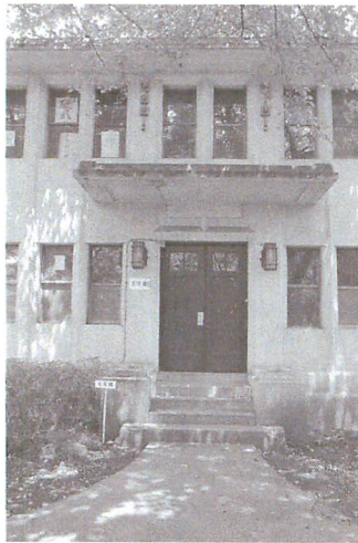
写真2 | 東寮外観（玄関）
