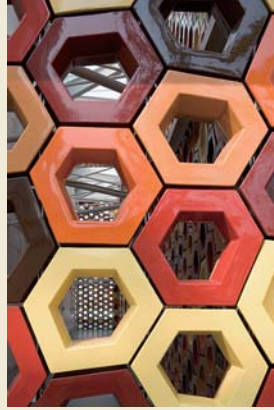
スペイン館(設計: foa)の外壁に組み上げられた6色のセラシア(格子窓)
